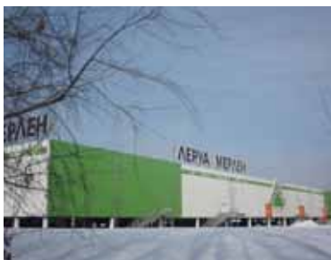
Leroy Merlin kereskedelmi központ
