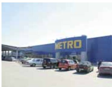
METRO kereskedelmi központ
